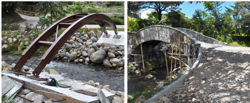
Construcción de puente grande (de cemento)
